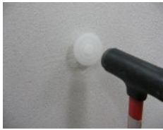
アンカーの打ち込み
