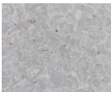
写真 8 ステン鍍 2度塗り
